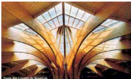
Figura 5: Exemplo de construções com vigas laminadas Fonte: Palais des Congrès de Besançon
