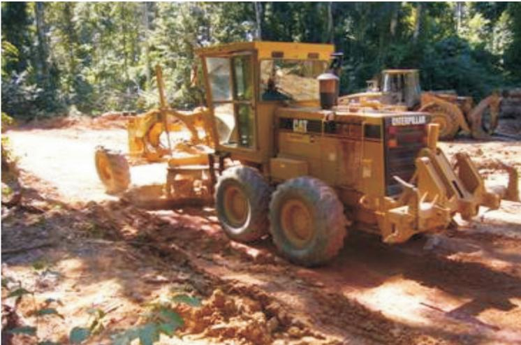
**Fig. 50.** Manutenção de estrada principal com motoniveladora na AMF da empresa Precious Woods Belém, em Pacajá, PA.
