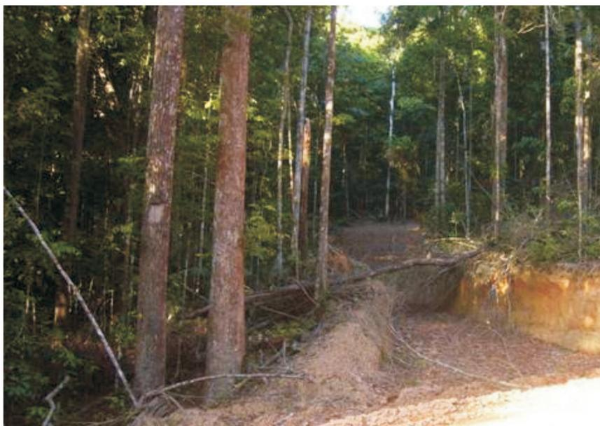
**Fig. 19.** Corte na beira da estrada principal para facilitar o escoamento da água na AMF Projeto Riacho Monte Verde, da empresa Precious Woods Belém, em Pacajá, PA.
