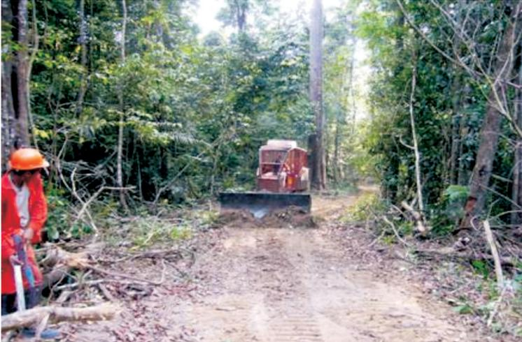
**Fig. 49.** Nivelamento com lâmina de trator de esteira como parte da manutenção de estrada secundária na AMF Água Azul I (Breu Branco, PA), da empresa IBL.
