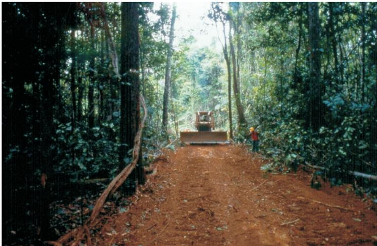
**Fig. 17.** Construção de estrada principal. Com operador treinado e a máquina apropriada, consegue-se uma alta produção (200 metros de estrada por hora) e redução dos custos.
